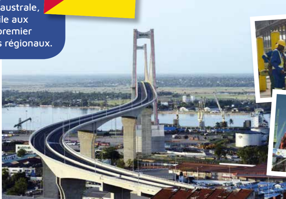
Le pont sur la baie de Maputo jusqu'à la ville de Catembe.
